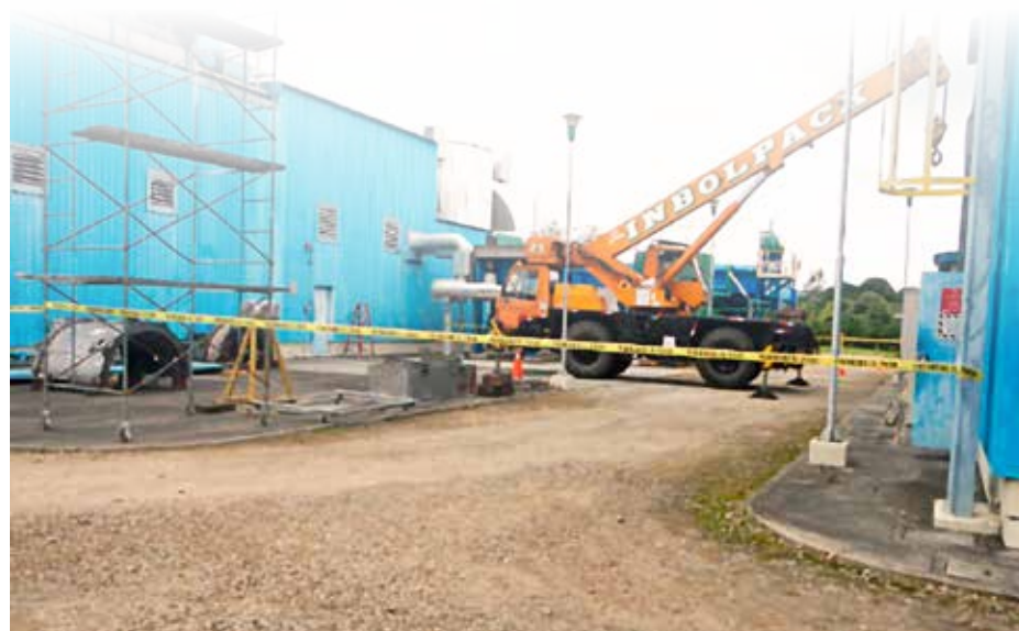
▲ Delimitación del área para trabajos con grúa en la Central Termoeléctrica Carrasco
