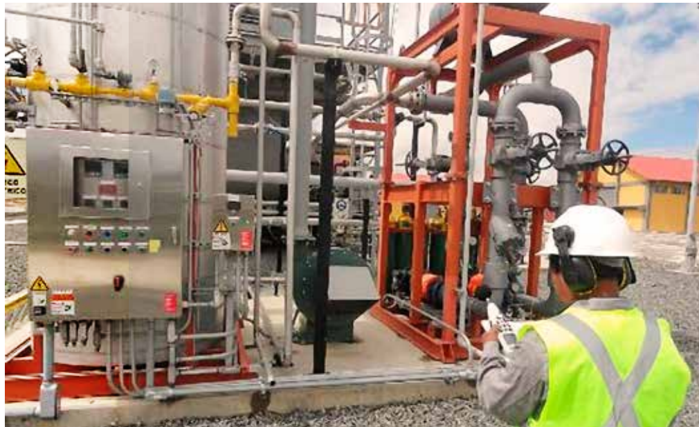
▲ Medición de niveles sonoros de ruido industrial efectuado por Laboratorio Ambiental Punto Alto – Central Termoeléctrica El Alto
