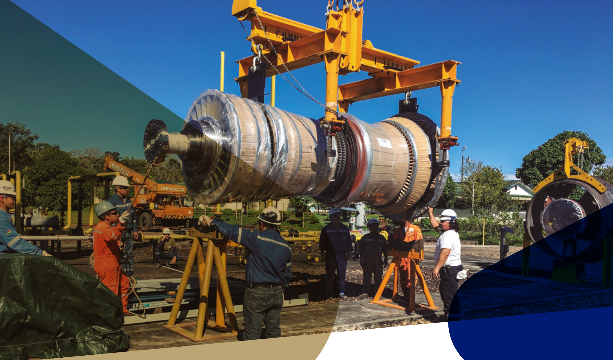
INSTALACIÓN DE ROTOR - UNIDAD GENERADORA CAR02 - CENTRAL TERMOELÉCTRICA CARRASCO G_1227
