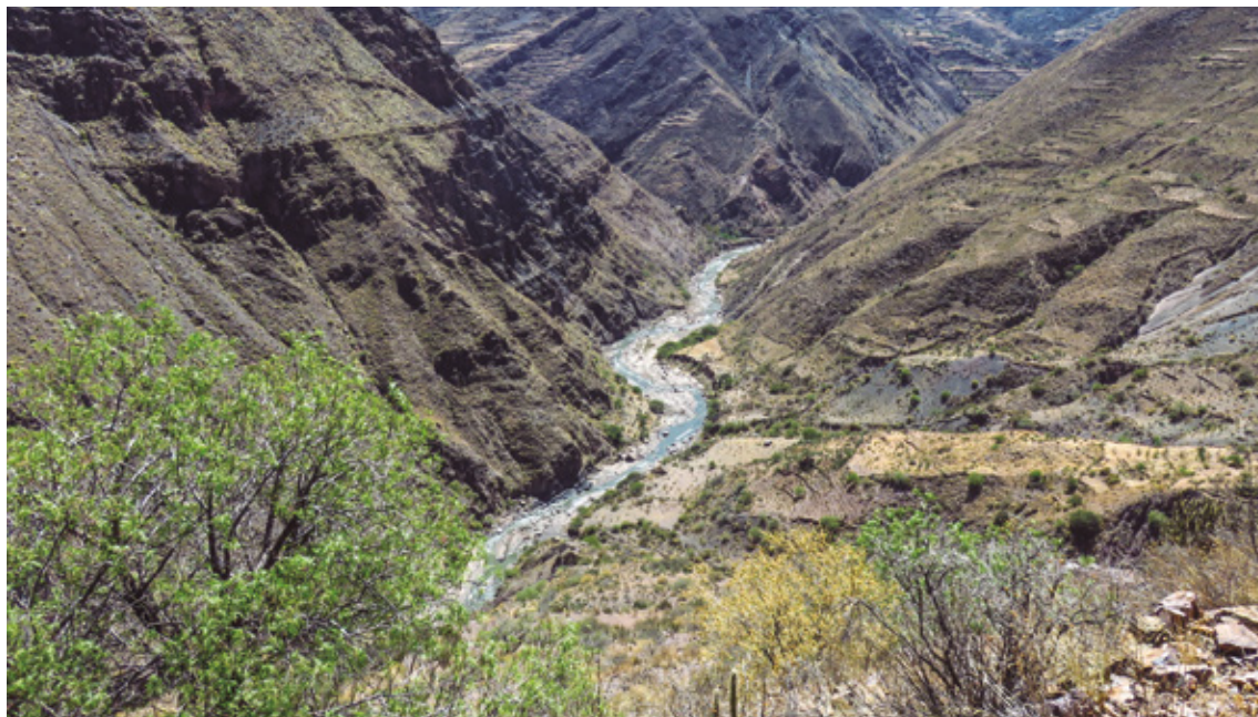
Río Chiuta, ubicación de la presa de la CH Chiuta PDH Chayanta
