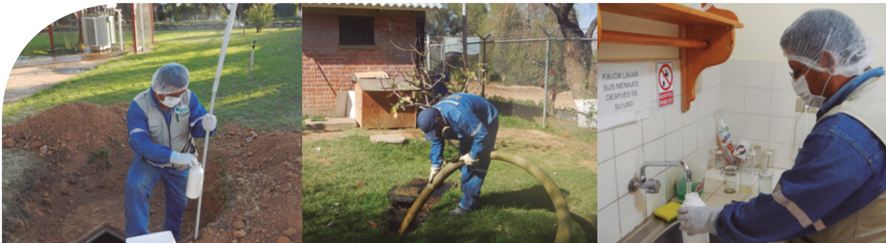
Muestreo de agua de grifo en cafetería, muestreo de agua residual en cámaras sépticas y mantenimiento correspondiente, realizado por Servicios Externos Especializados - Central Termoeléctrica Valle Hermoso
