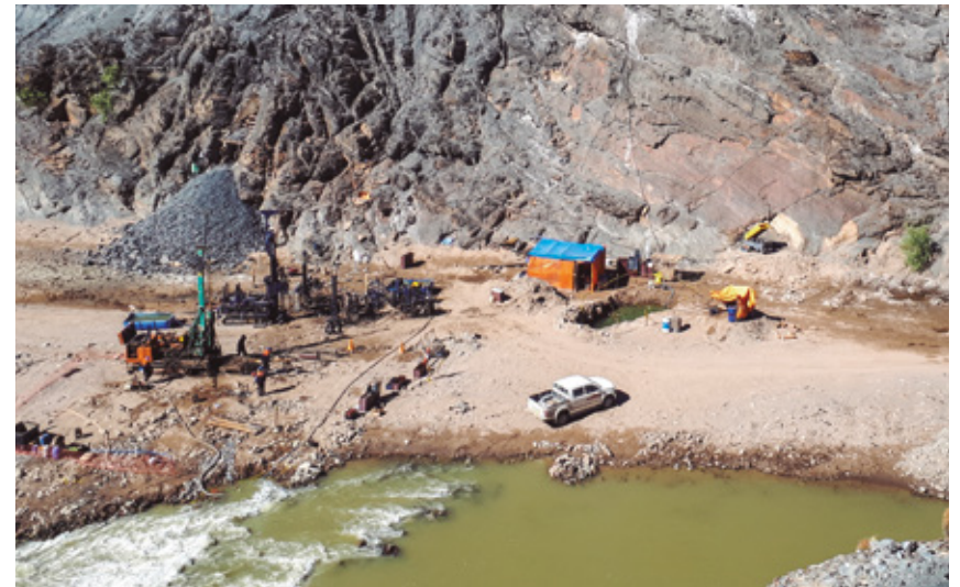
Investigaciones geológicas-geotécnicas en el sitio de presa
