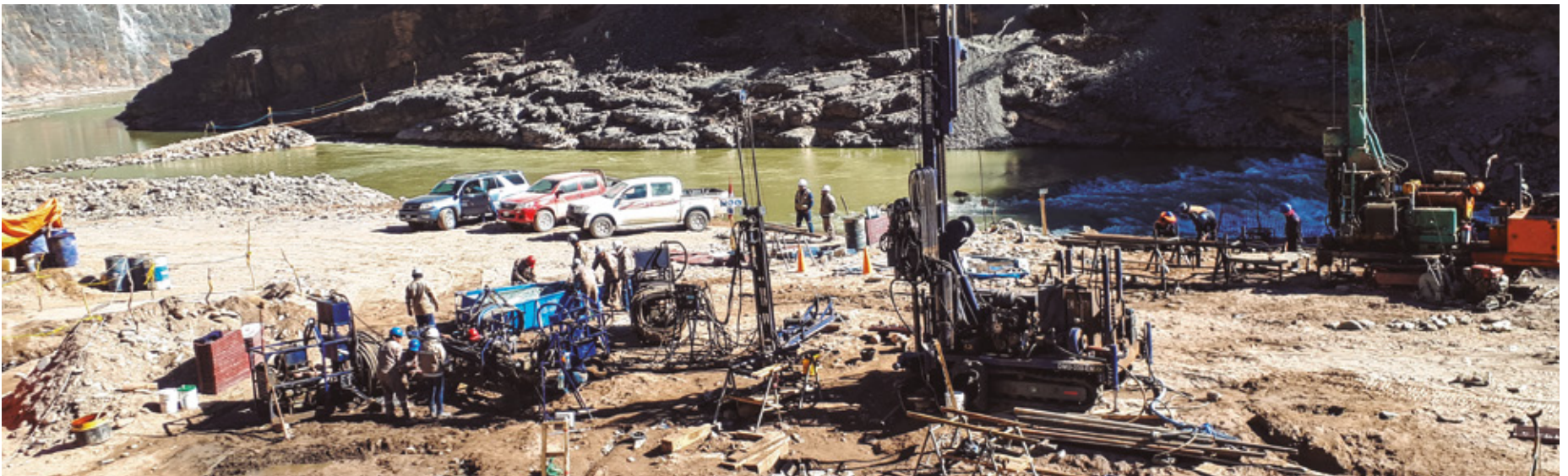
Investigaciones geológicas - geotécnicas en el sitio de presa
