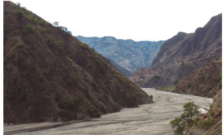
Ubicación de la presa de la CH Kirki PDH Chayanta
