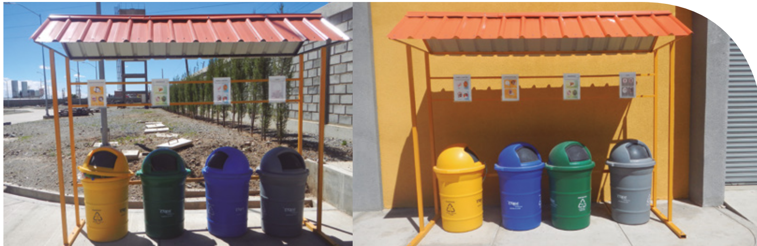
Implementación de Áreas de Disposición de Residuos y Contenedores Diferenciados - Central Termoeléctrica El Alto
