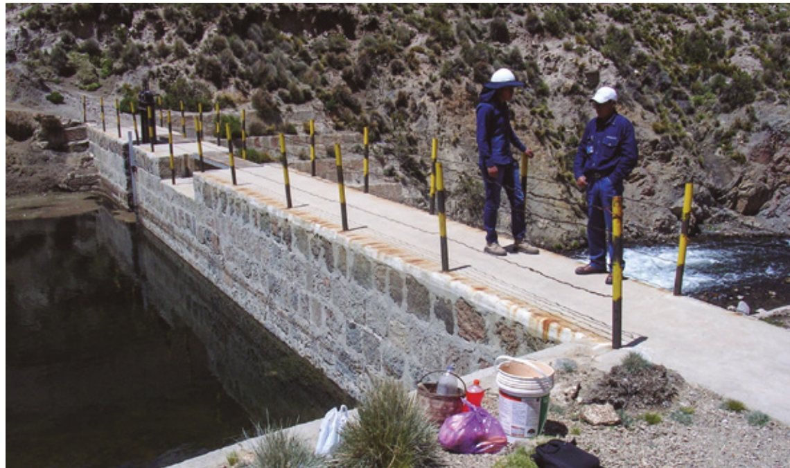
Presas Aguas Calientes Central Hidroeléctrica El Cóndor
