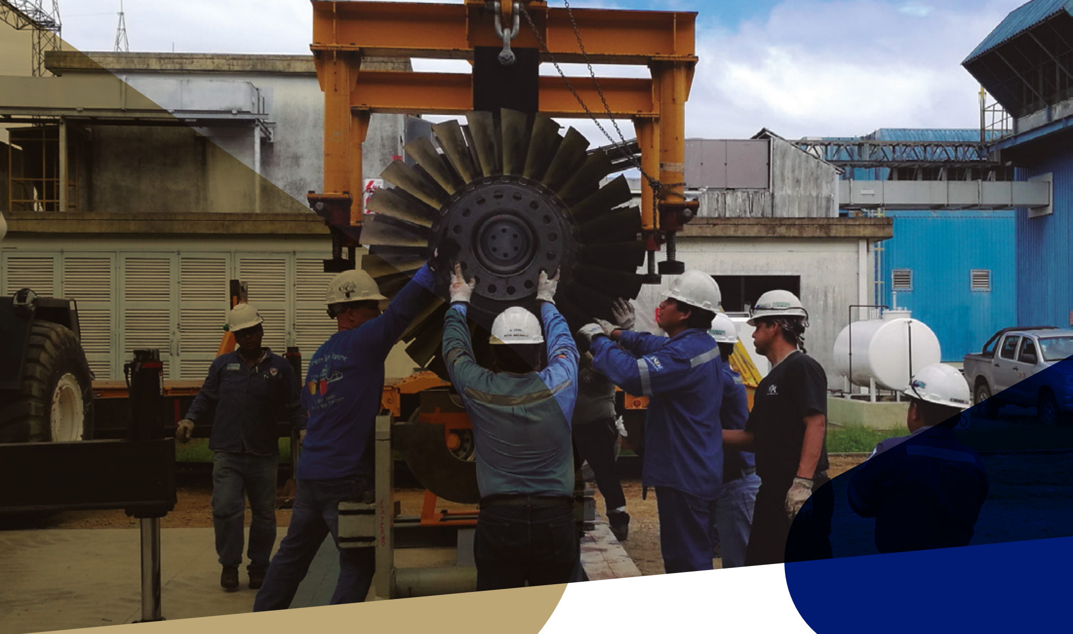
INSTALACIÓN DE ROTOR - UNIDAD GENERADORA CAR02- CENTRAL TERMOELÉCTRICA CARRASCO
