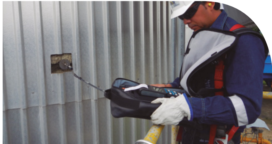
Monitoreo y medición de Gases de Escape a Unidad CAR 01 – Central Termoeléctrica Carrasco
