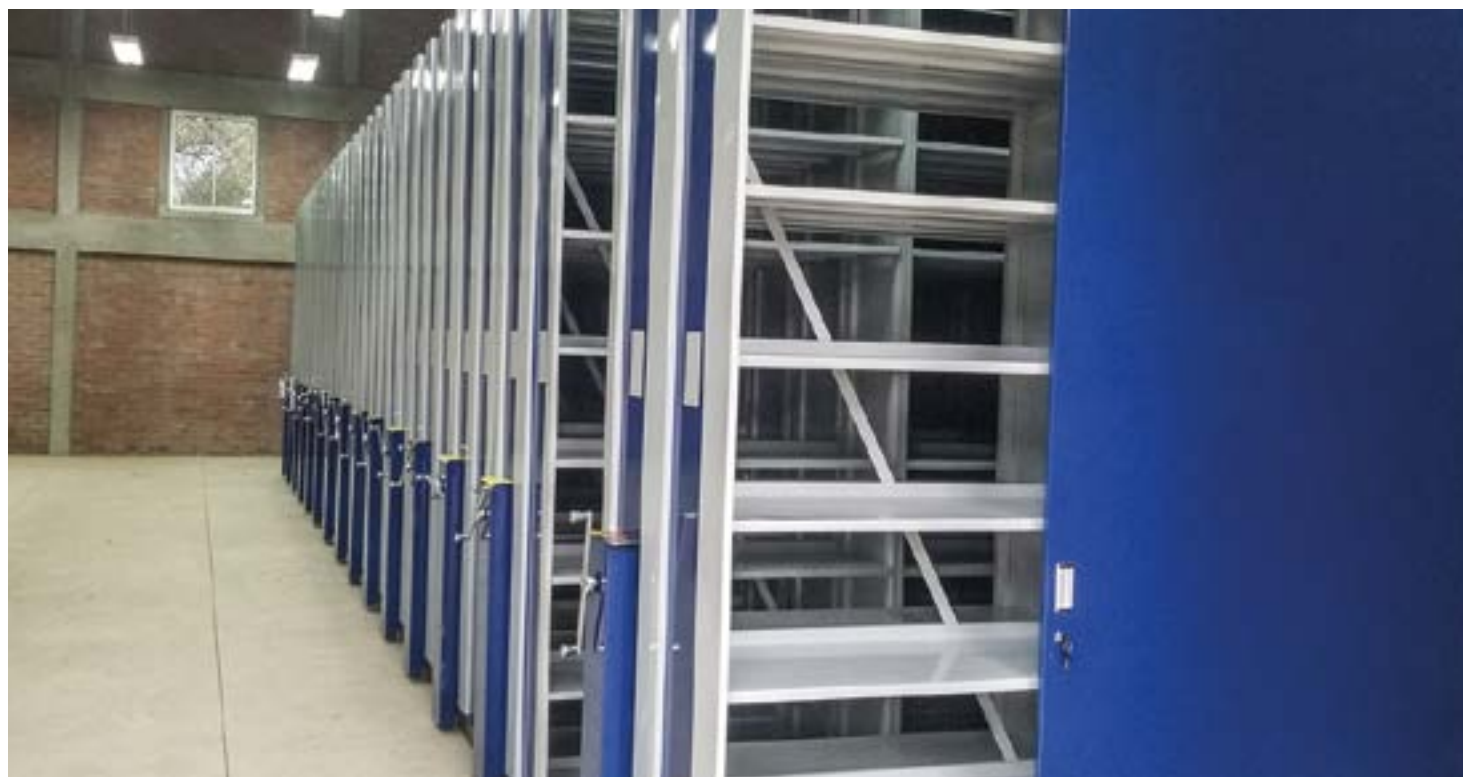
Edificio de Archivos – Central Termoeléctrica Valle Hermoso
