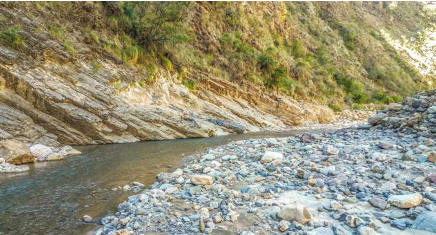
Ubicación de la presa de la C.H. Chaka
