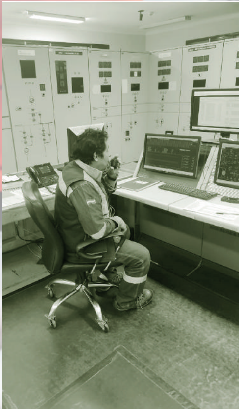
Simulacro Incendio – Personal Central Termoeléctrica Carrasco
