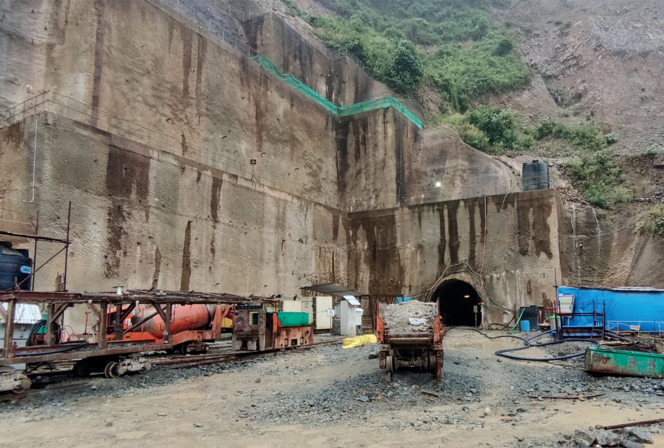
Portal de Entrada Túnel Sehuencas - PHI
