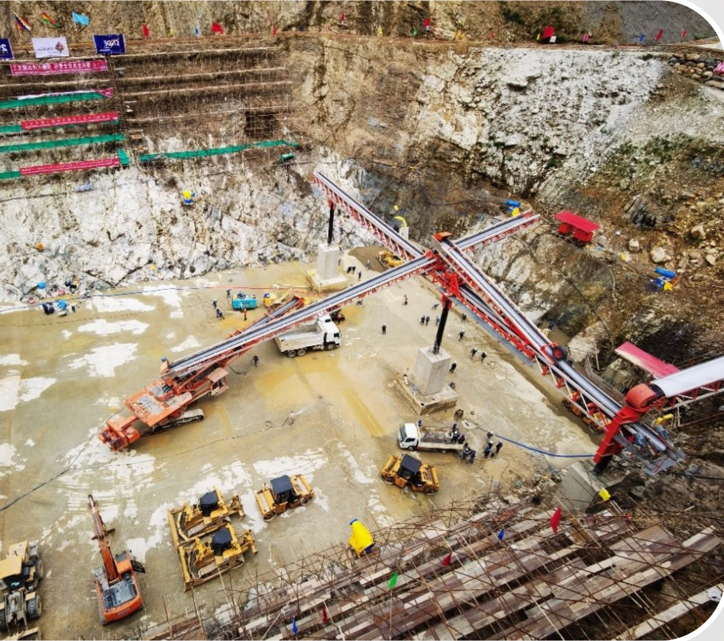
Trabajos de colocación de HCR presa Sehuencas 13/10/2021
