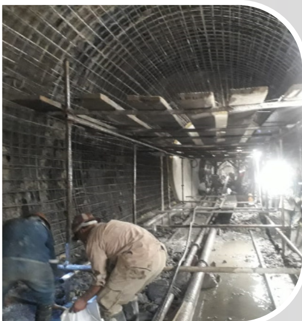
Revestimiento tramo final – Túnel Sehuencas
