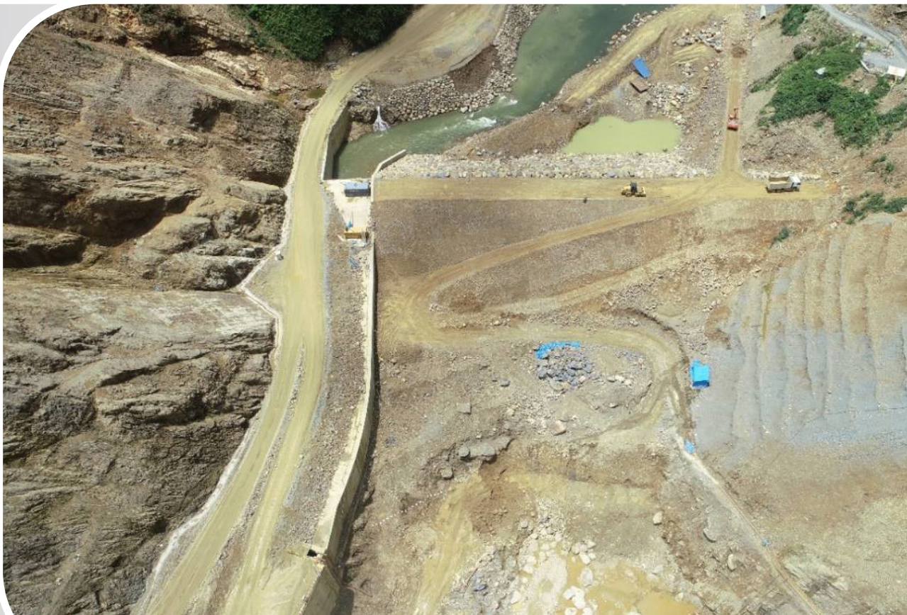
Ataguía aguas arriba presa Sehuencas 28 de enero de 2021
