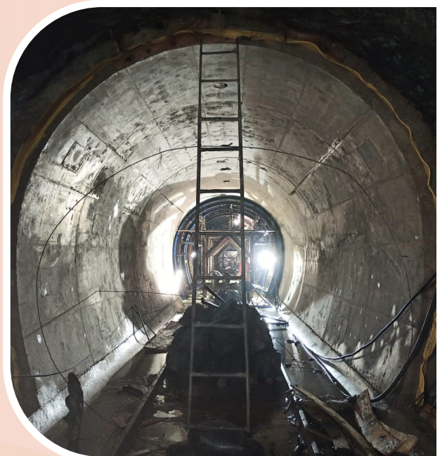
Revestimiento tramo F7– Túnel Juntas
