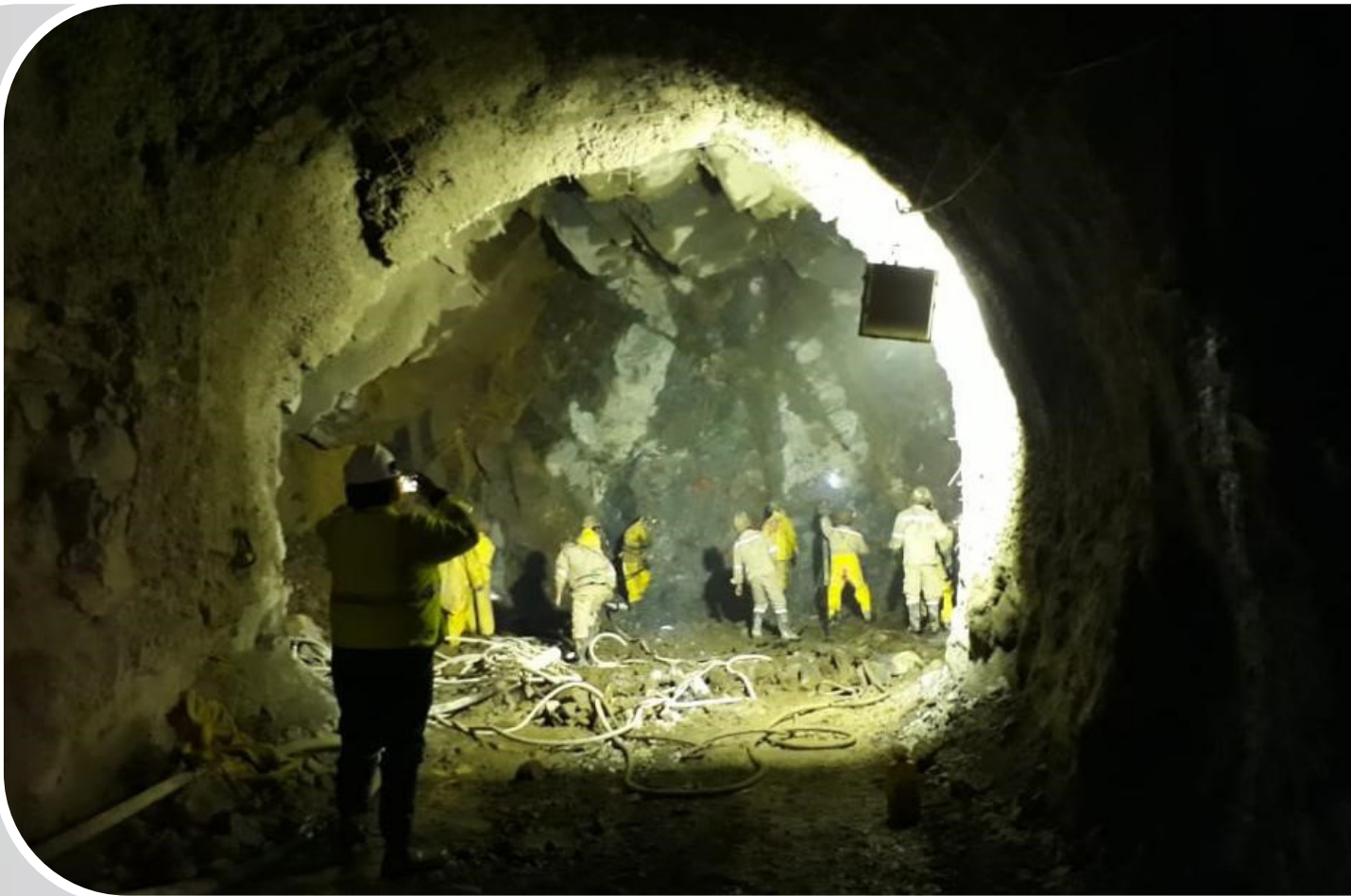
Excavación primer ensanche – Chimenea Sehuencas
