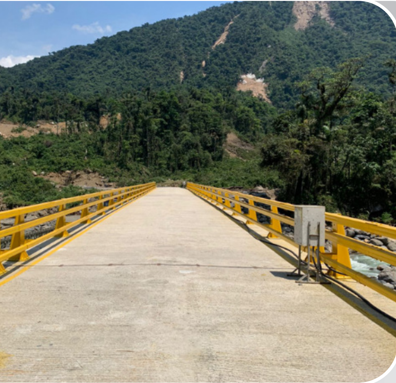
Cumplimiento Hito 2 Finalización de obras en los ejes 4, 5, 6, 7 y 8 incluidas obras de drenaje y estructuras
