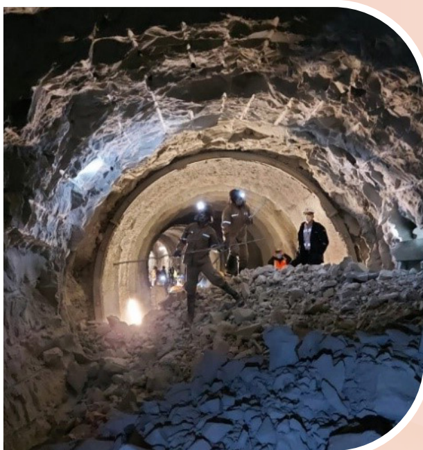
En fecha 18 de octubre se ejecuta empalme entre los frentes F7 y F8 – Túnel Juntas
