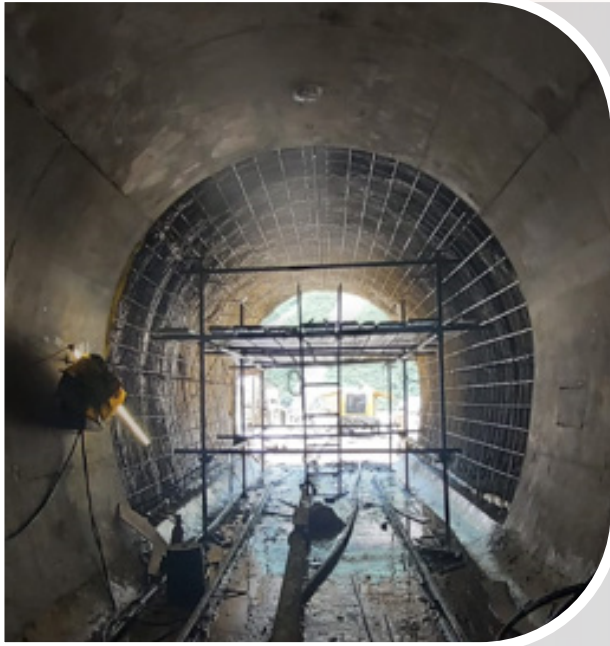
Revestimiento tramo final – Túnel Sehuencas
