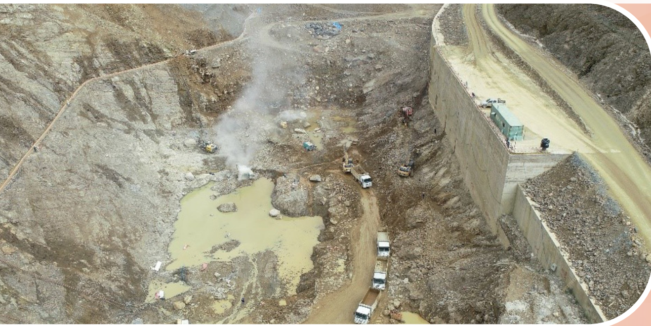
Excavación presa Sehuencas
