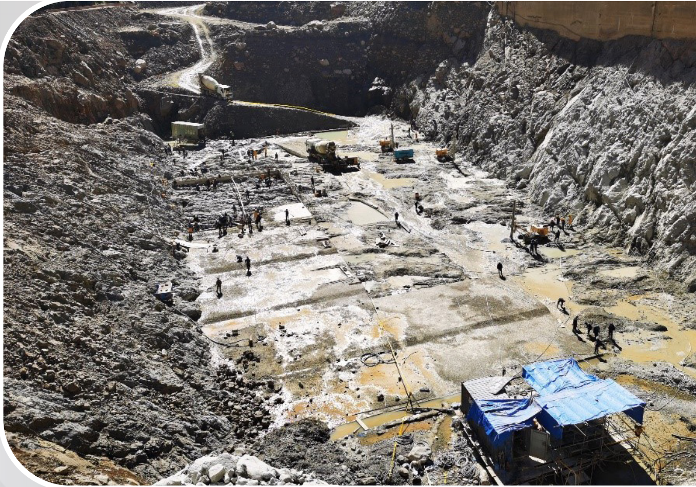
Excavación presa Sehuencas
