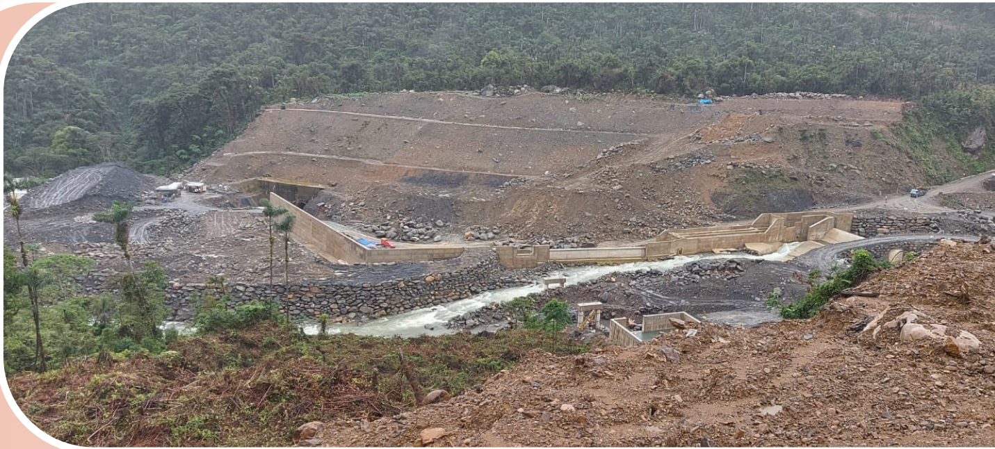
Obra de Toma Juntas
