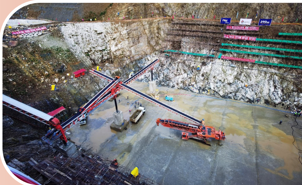
Preparación de superficie lista para colocado de HCR presa Sehuencas 13/10/2021
