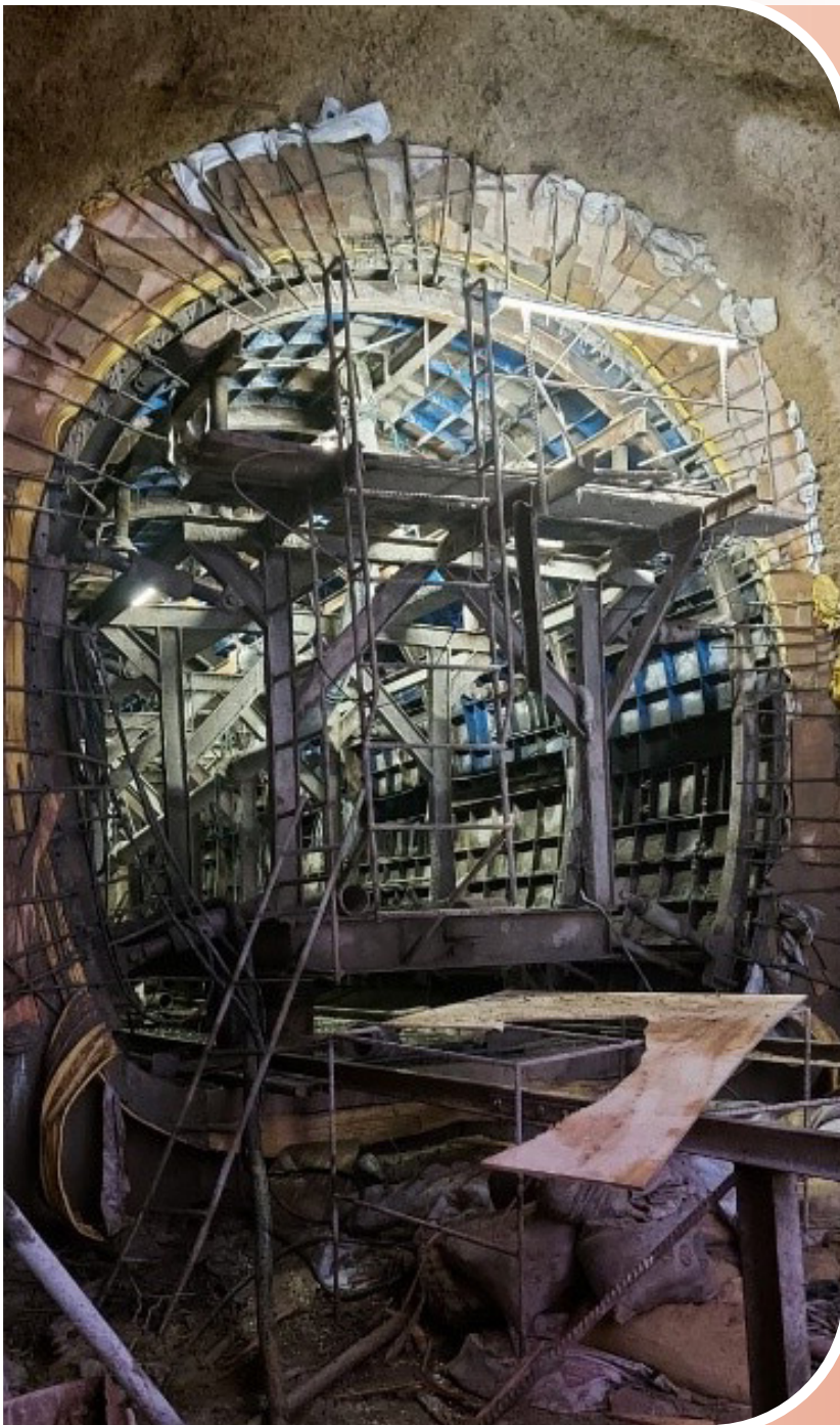
Hormigonado de tramo de intersección pozo y túnel Obra de toma Sehuencas
