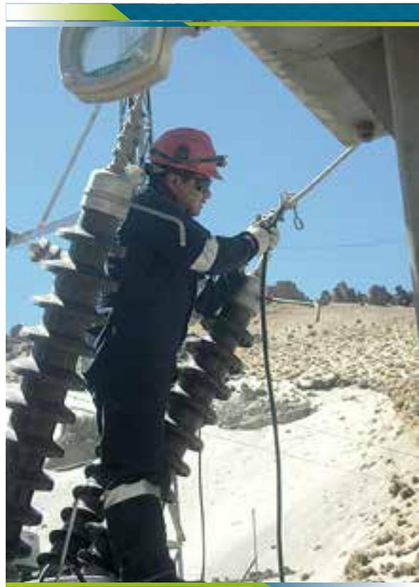
Mantenimiento y ajuste de pernos en subestación Landara
